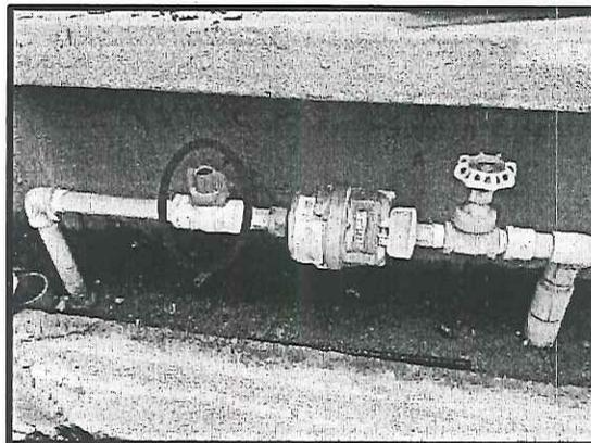
Este elemento es la válvula que permite hacer de manera técnica la suspensión del servicio a un inmueble, cuando existe incumplimiento del contrato de condiciones uniformes por parte del suscriptor o usuario, como el no pago de las facturas vencidas. La suspensión del servicio, cuando no se cumplen las condiciones del contrato, es un derecho de los prestadores de servicios públicos domiciliarios.
